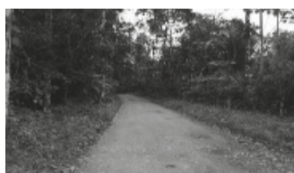
Vía lastrada en condición desfavorable
