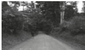
Vía lastrada en condición desfavorable
