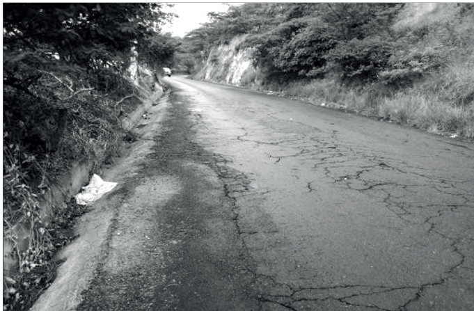
Capa de rodadura en malas condiciones.
